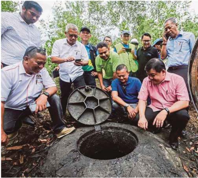
PENGERUSI Jawatankuasa Tetap Alam Sekitar, Teknologi Hijau, Sains, Teknologi dan Inovasi dan Hal Ehwal Pengguna negeri, Hee Loy San (kanan) melihat saluran pembetungan yang tercemar di Bandar Bukit Mahkota, Bangi, semalam.
