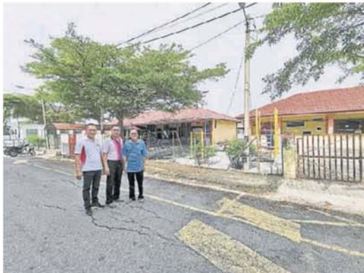
■仁小学前教育班校舍屋顶漏水，也获得维修，左起为颜俊才、陈福生及郑联荣。
